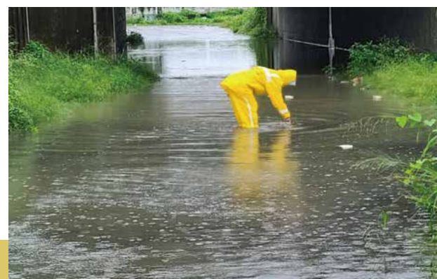
0730豪雨_涵洞排水溝雜物排除
