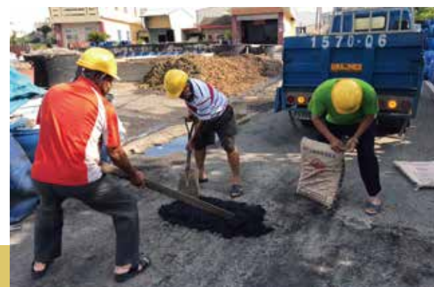
社區成員填補破損道路
