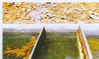
地面雨水逕流處理渠(系統)
