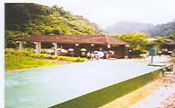
溫帶動物區地面逕流雨水貯留系統(250立方公尺)
