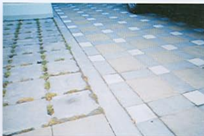
結合溢流雨水設置透水磚擴大應用
