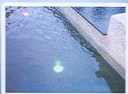
兼具都市防災與景觀綠化的雨水貯留系統
