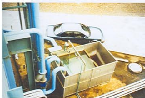
與冷凝水合併應用之雨水貯水槽
