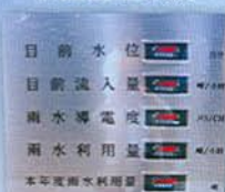
雨水即時水質/水量監控系統
