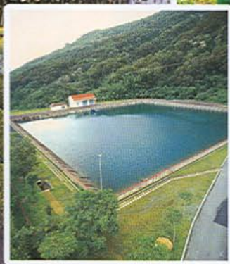
收集山泉水(地面逕流雨水)之雨水槽
