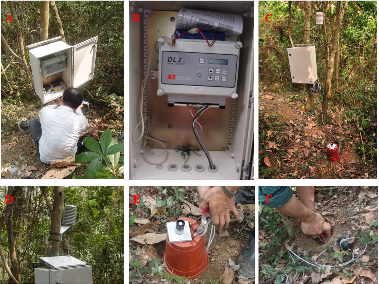
圖 1. 氣象資料紀錄器架設情形。(A) 安裝主機。(B) 主機。(C) 氣象資料紀錄器全景。(D) 大氣溫度、濕度計。(E) 光度計。(F) 土壤溫度、溫度計。
