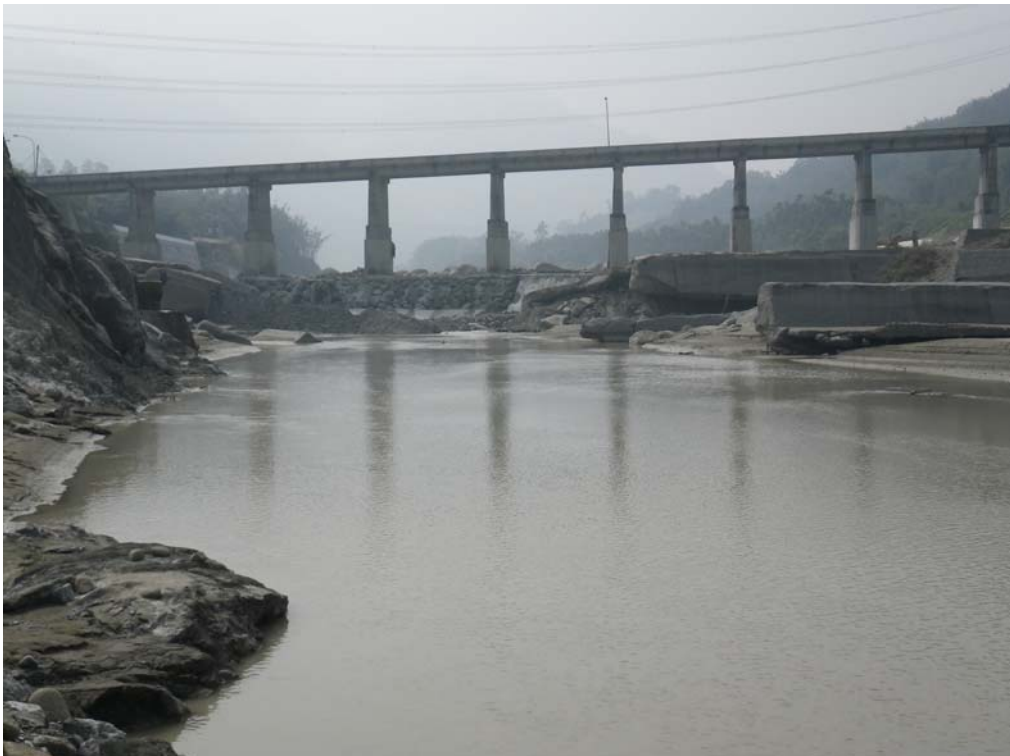
圖 25. 清水溪行正橋下防砂壩照 (2010 年 3 月)
