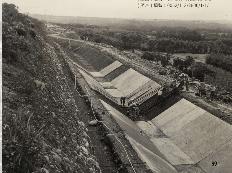
▲ 石門大圳幹渠明渠段的設計圖（左，工圖號：MC-T-01 石門大圳幹渠明渠內面工設計圖）與施工情況（右、下），工人們須先將渠道挖出後，妥善整平再鋪上防水層（右）、最後以混凝土鋪平渠道表面（下）。
