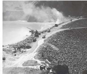
▲ 上游擋水壩填築工程。導水隧道完工後，上下游擋水壩與大壩主體填築工程隨即展開。
