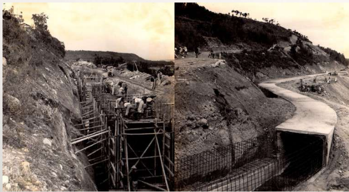
▲ 石門大圳幹渠暗渠段的施工情況，工人們以鷹架、模板輔助下，搭建鋼筋結構，再進行灌漿、防水層處理，最後再覆土，將石門大圳暗渠水道逐步完成。
