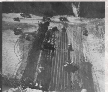
▲ 大壩主心附近濾層及殺層填築。
