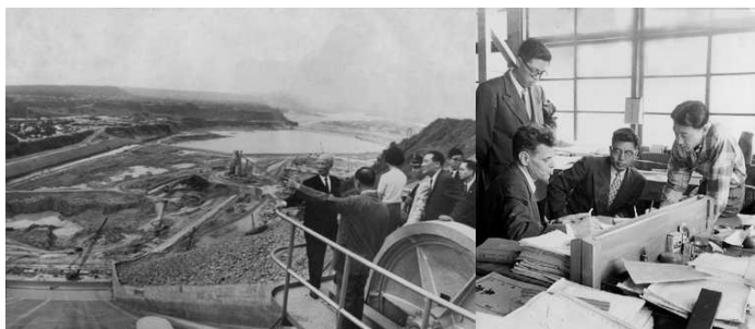
▲石門水庫工程對民生發展影響甚鉅，深受當時政府重視。照片中為陳誠副總統於溢洪道開門聽取總工程師顧文魁與執行長徐鼎之報告。
