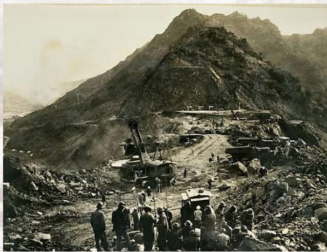
▲ 民國 49 年 1 月，在壩體工程重新論證檢討之際，其他部分工程仍在緊鑼密鼓的進行中。圖為溢洪道工程，山脊部分施工情況。《莫克國際公司 石門水庫工程月度報告第 10 期》 檔號：0049/A700/1602/1/001
