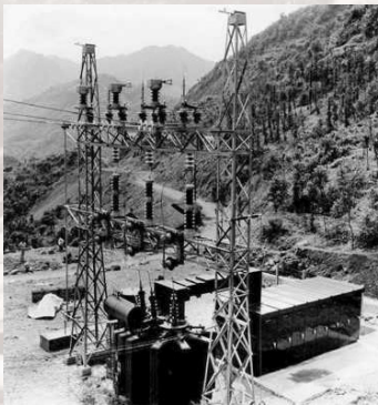
▲ 石門發電站輸電工程
