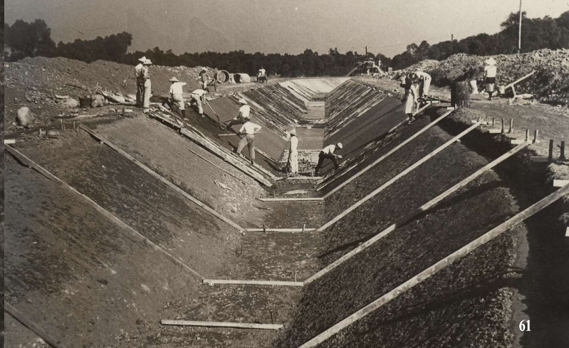
▲石門大圳系統及施工分段圖。石門大圳幹渠長 27.36 公里，支渠 18 條長 101.22 公里，分渠 43 條長 175.74 公里，灌溉區包括標高 250 公尺以下至桃園大圳及光復圳灌區邊界之地勢較高台地，面積約 23,000 公頃，涵蓋三縣十二鄉鎮。
