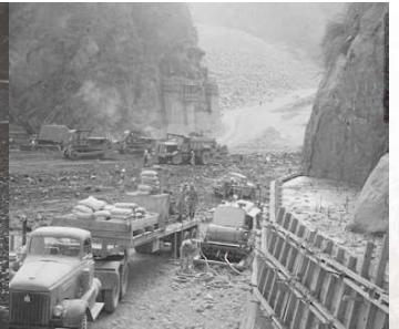
▲ 大壩主體工程。上下游擋水壩間之旱地即為大壩主體工程所在，主體工程前還需對兩側山壁進行補強加固。
