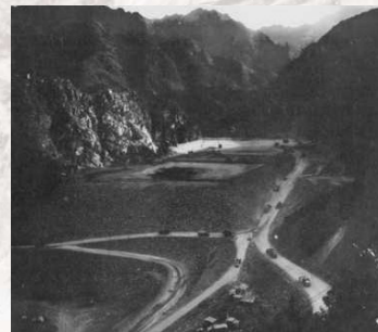
▲ 隨著土石壩工程日以繼夜地進行填築，石門大壩的壩體逐步升高。《施工月報第 44 號-1962 年 10 月》
