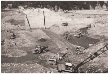
▲ 後池與後池壩工程
