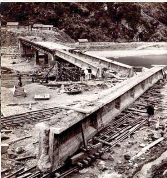
▲ 聯外道路先期工程：石門大橋
