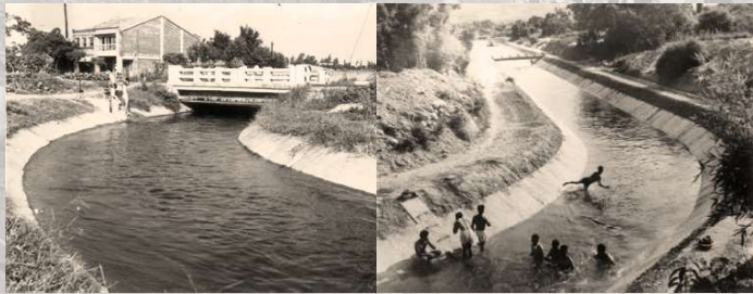
▲ 石門大圳幹渠送水情形
