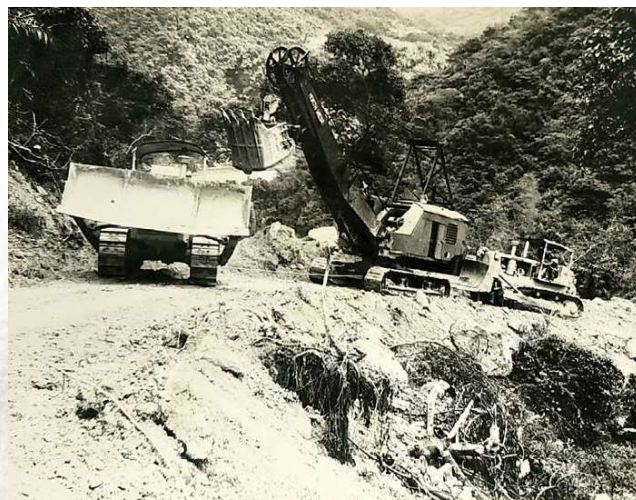
▲許多美製大型工程機具與車輛因石門水庫工程的關係，首次被引入臺灣。《莫克國際公司石門水庫工程月報第 5 期》
