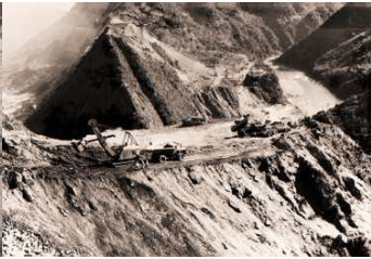
▲ 民國 48 年 12 月，大壩左岸標高 270 公尺處，正在進行加固工程。《莫克國際公司石門水庫工程月度報告第 9 期》
