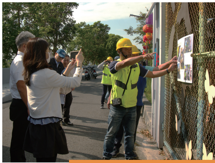
臺南市仁德區二行社區 - 巡查大甲堤防水門抽水設備
