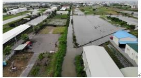
巡查大雨後的排水線
