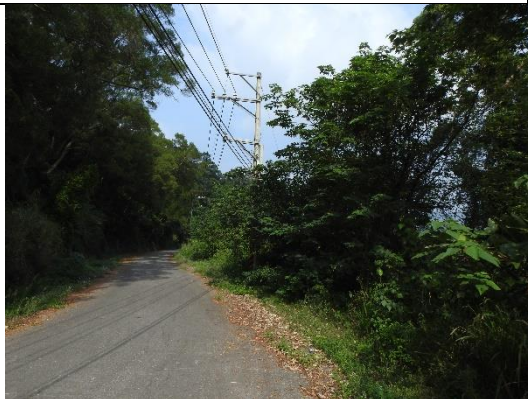
鄰近區域環境現況-道路
