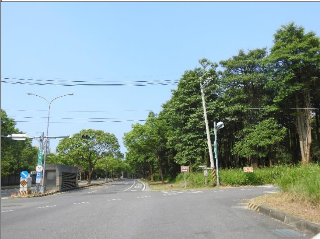
圖 2.3-5 第二工區施工起點 (111.10.04)
