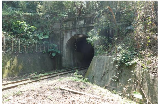
圖、舊山線既存設施
