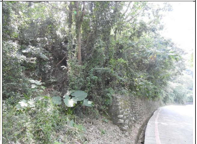
圖 2.3-6 第二工區斜坡下植被狀況 (111.10.04)
