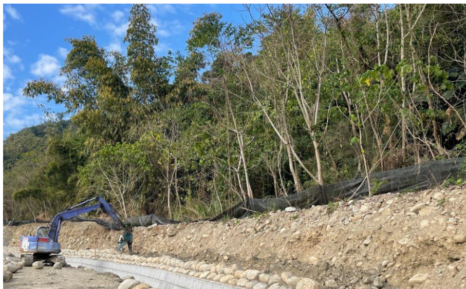
圖 3.6-3 農委會水土保持局台中分局茄冬寮野溪工程黑網圍設
