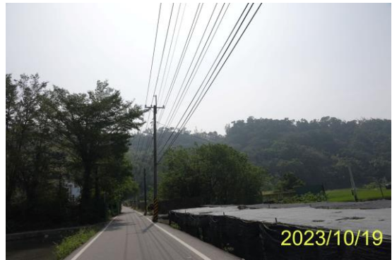
圖、三工區自北往南
