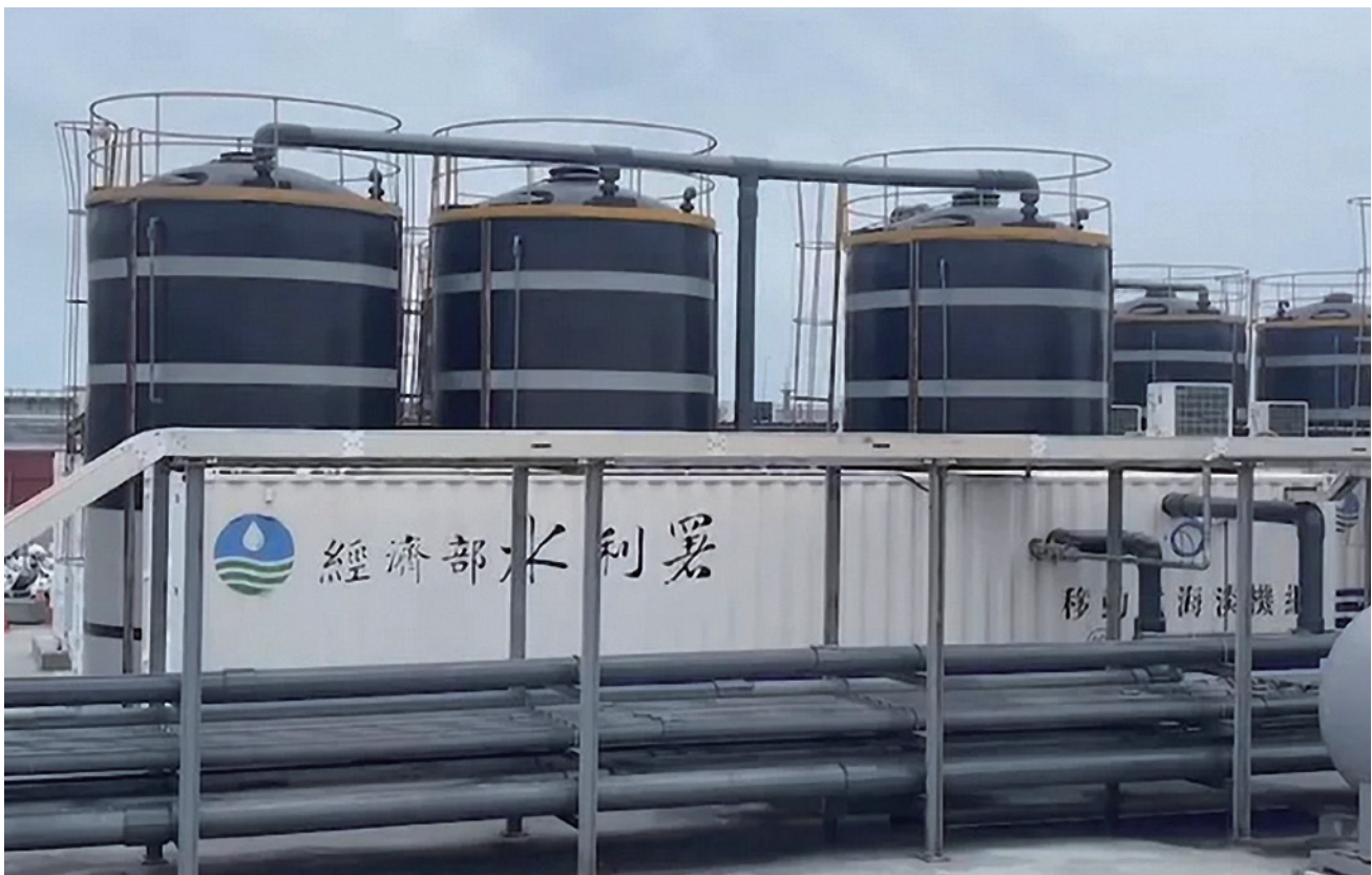
圖 4、永安興達電廠設置緊急海淡機組
