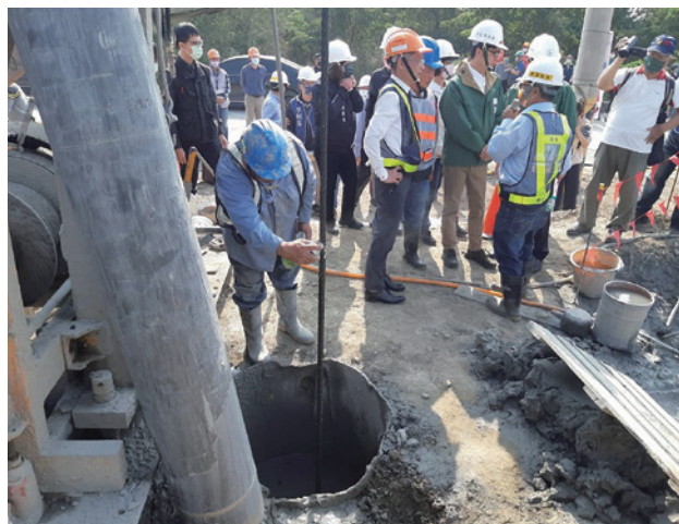
圖 3、抗旱水井施工照片
