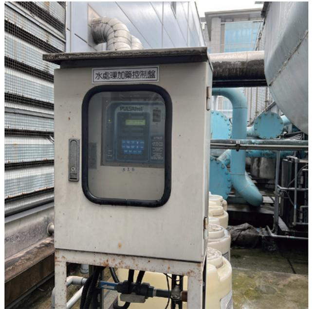
圖 3、空調冷卻水安裝自動加藥設備
