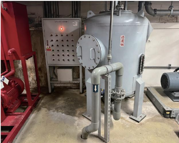
圖 4、雨水過濾設備
