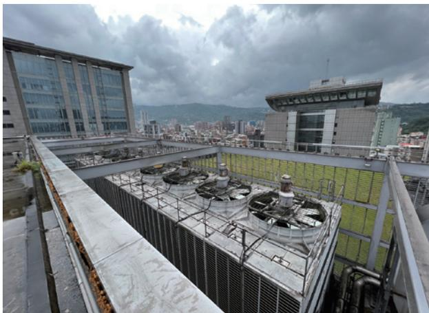
圖 2、空調冷卻水塔安裝溫控啟停控制
