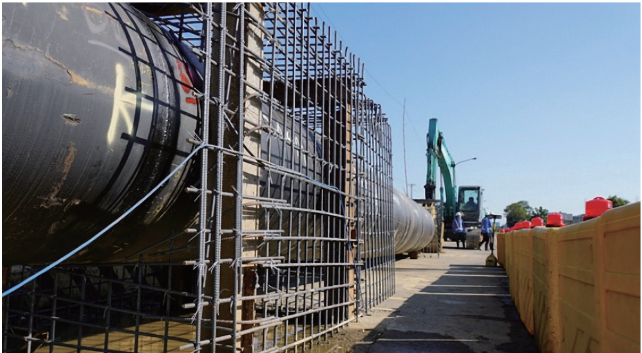
圖 1、桃園新竹備援管線施工
