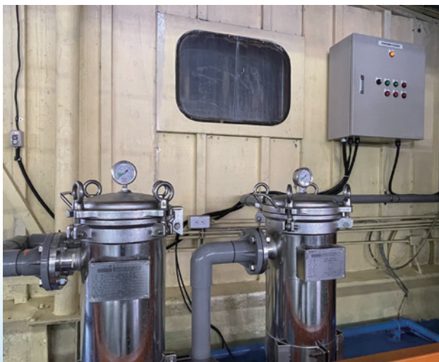
圖 4、乘用車試漏棚水回收再利用
