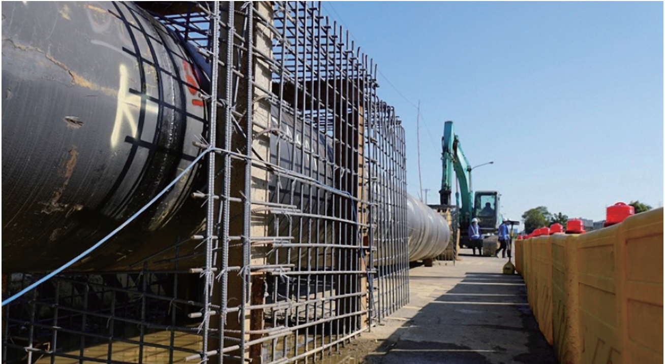
圖 1、桃園新竹備援管線施工
