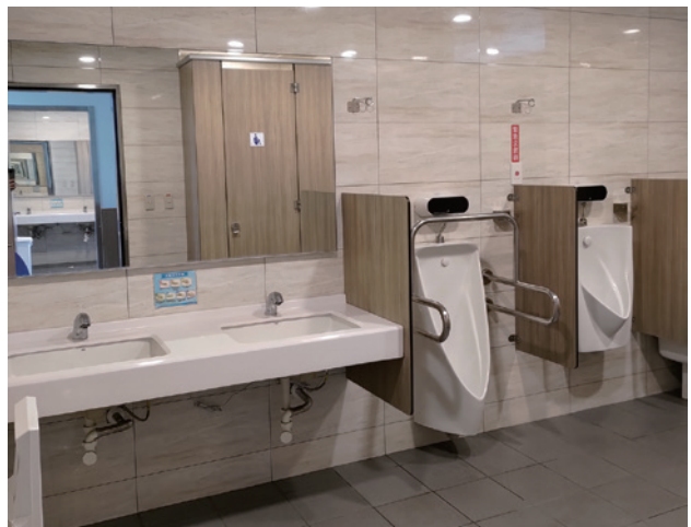
圖 1、廁所改建，全面換裝省水器材
