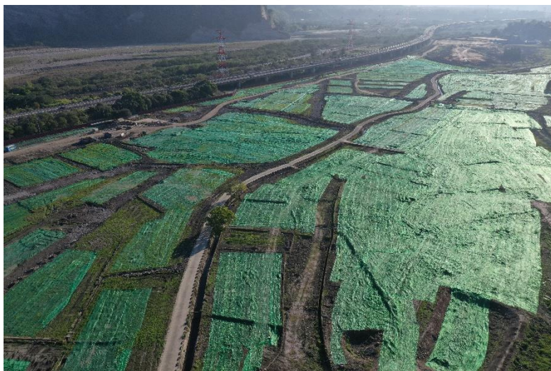
湖區清除掘除後 鋪設防塵網
