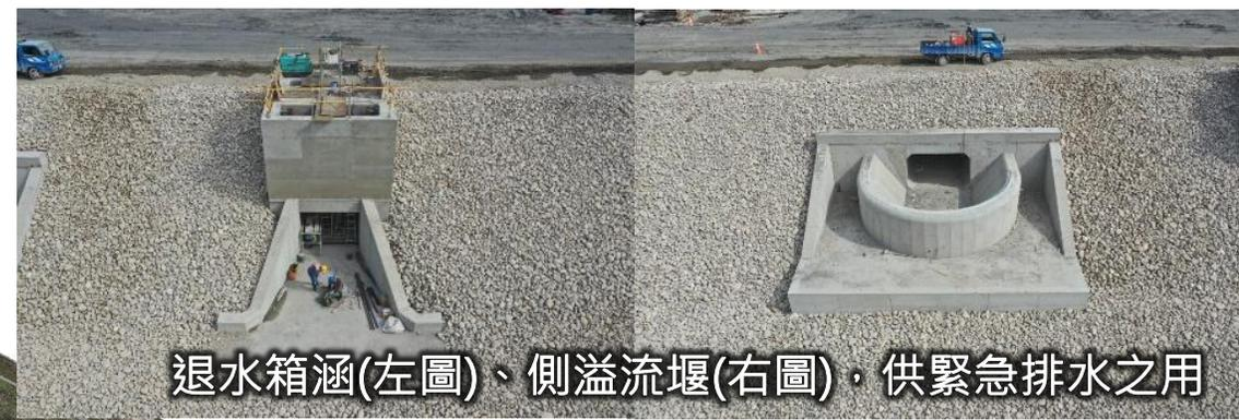
退水箱涵(左圖)、側溢流堰(右圖)·供緊急排水之用
