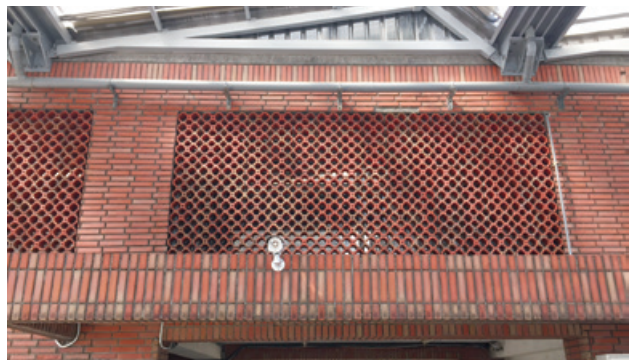
雨水收集管線
