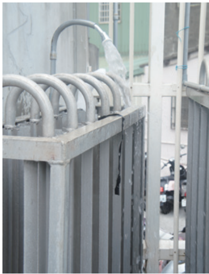
液氧蒸發器灑水加裝冰水回收與示意圖
