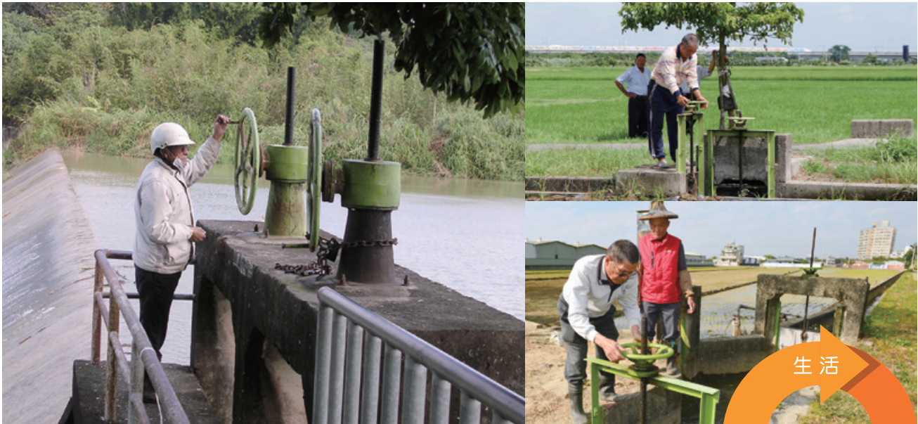
圖 2. 嘉南灌溉區掌水工調控用水水門照片
