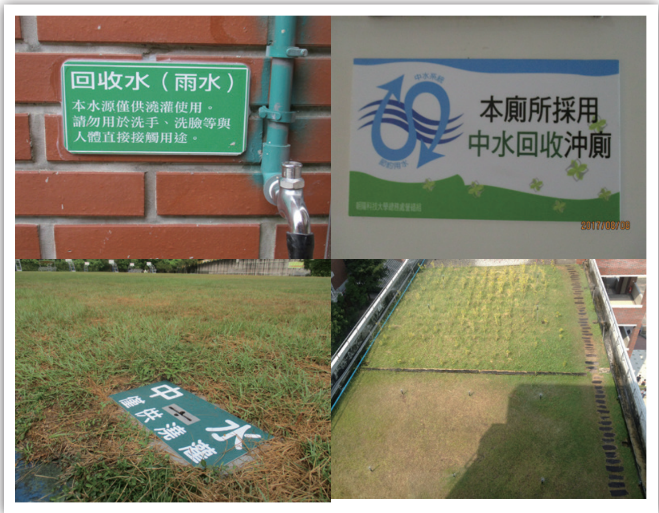
水資源再利用 (左上：雨水利用；右上：中水沖廁；左下：中水澆灌；右下：RO 廢水綠屋頂澆灌)
