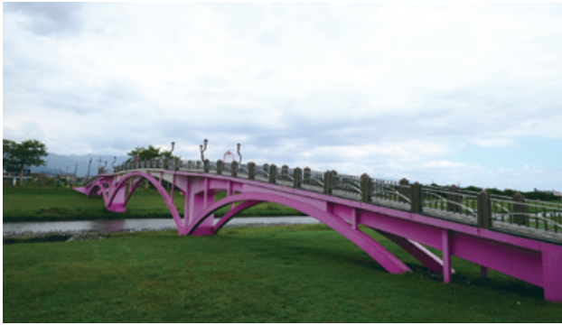
跨越安農溪拱橋
