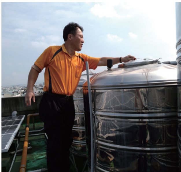
每月定期檢修水塔及管線
