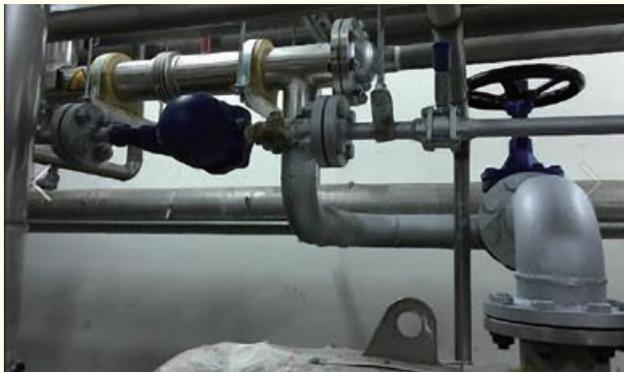
圖五、熱泵加裝冷凝水系統
