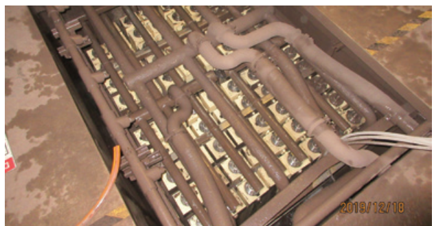
圖 4、BGW 研磨廢水回收系統 (MBR 微濾膜)
