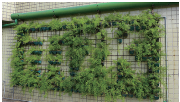
圖 2、海大河工二館立面收集雨水作為植栽澆灌
