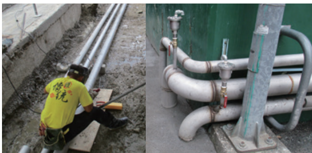
圖 4、給水管線汰換
