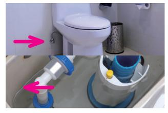
方法二:將進水角閥先行關閉,等待5分鐘後量測水位下 降高度。(每下降 1 公分約漏水 700 cc)
