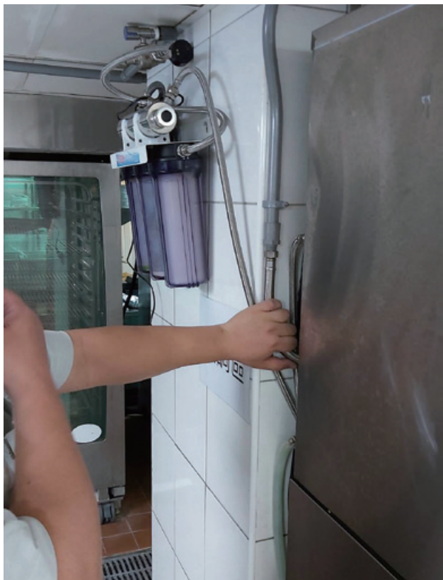
圖 5、用水設備巡檢管路實況
