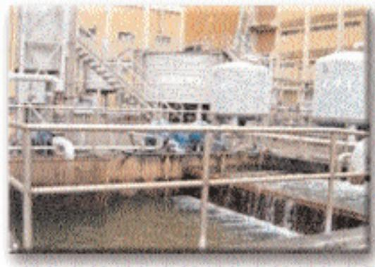
▲ 圖3 綜合廢水處理設備，收集機組廢水，處理後回收再利用
