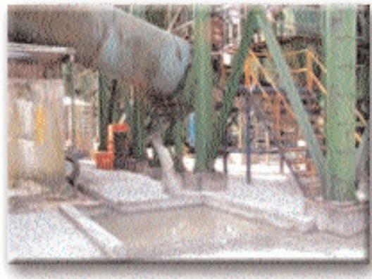
▲ 圖2 拌合場洗車水回收再利用過濾池
