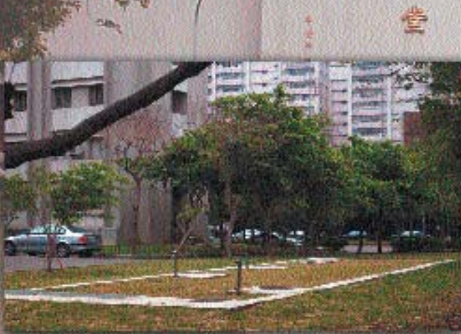
▲ 社區型大型地下雨水貯槽（150噸），除具集水利用功效外，對降低社區降雨洪峰流量有極大之助益(台中辦公區)
