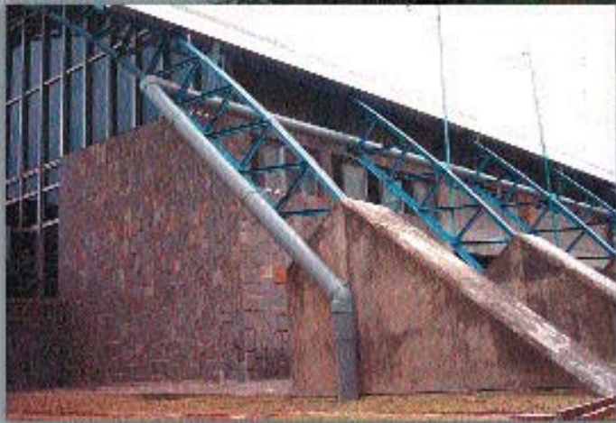
▲ 利用既有屋頂作為收集面積的第五河川局與水利署台中辦公區
