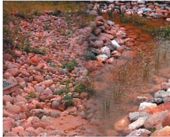
▲ 降雨洪峰浸透調整區與草溝的建立，為本基地帶來良好的城市洪峰減量的效果
