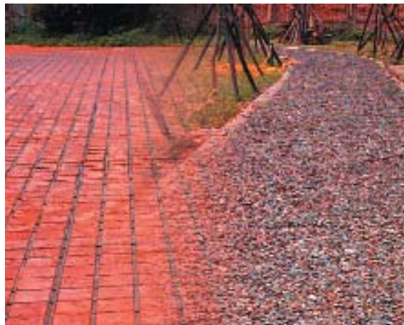
▲ 配合建築基地保水設計工法，納入地下水資源保育觀念設置整體結構型透水磚及碎石鋪道，在結構加強下為都市化地區土地帶來地下水補注的良好效益
