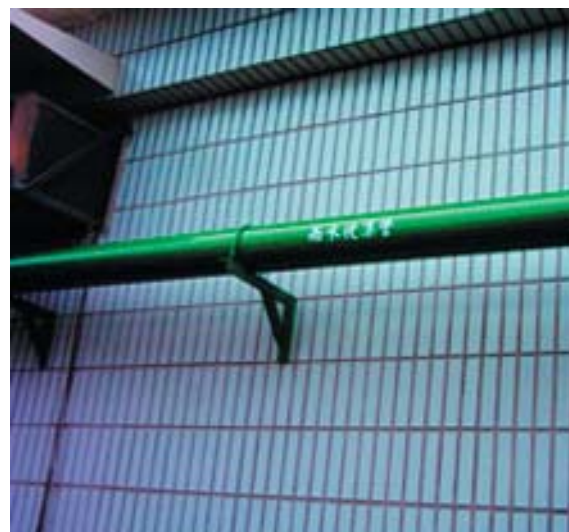
▲ 標示明顯之屋頂雨水蒐集管路 (依建築技術規則要求塗裝綠色與明顯標示)
