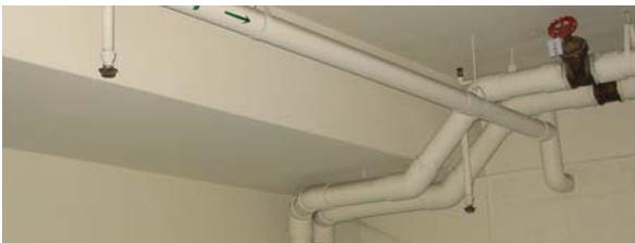
「昇陽國艷」地下一樓裝有雨水回收利用的管線，主要是將雨水經由管線輸送至位於地下三樓的貯水槽。
