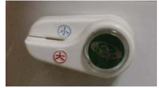
雨水經過過濾後用於校舍的沖廁用，沖廁也使用省水器材。
