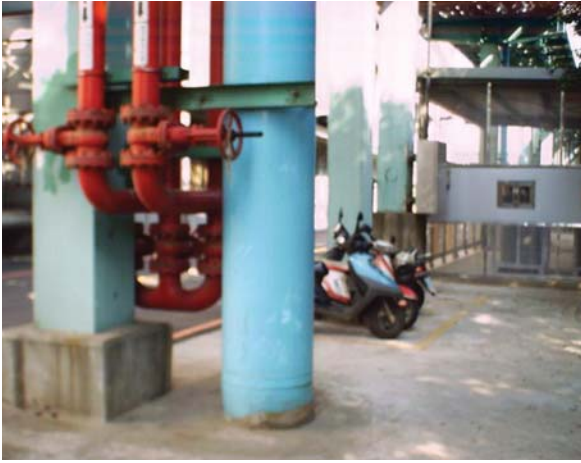
中華映管的雨水回收水管；地面下為貯水池。
