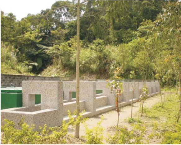
動物園的地面雨水處理系統及引水道
