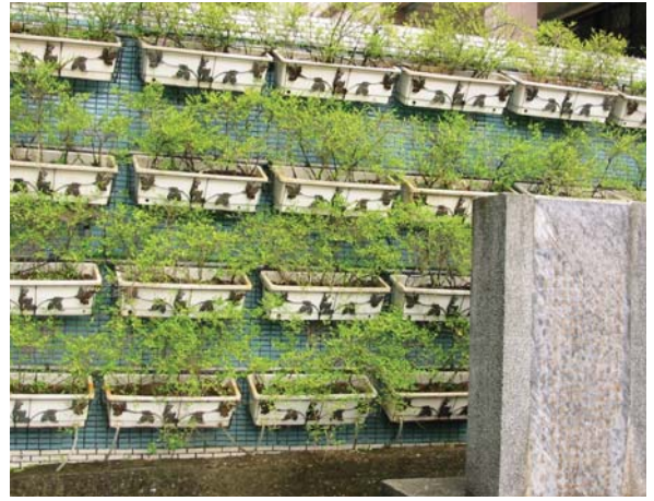
平溪國小將水資源有效利用的觀念應用在澆灌系統上，花盆以垂直排列方式，最上層花盆之溢流水便可導入第二層、依序第三層等，水資源一點都不浪費。
