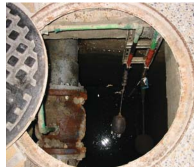
地下三樓的貯水槽約可儲存300噸的雨水供利用，到目前為止使用上綽綽有餘。
