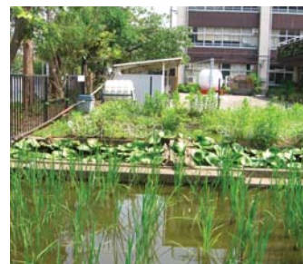
收集停車棚屋頂雨水做為生態池補充水源。
