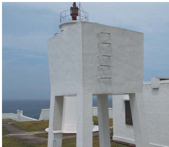
自來水高架水塔，由貯槽加壓至水塔後，供給日常生活用水。（鼻頭角燈塔）
