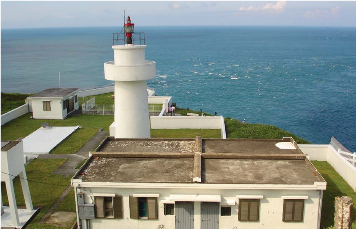
鼻頭角燈塔，宿舍屋頂為雨水收集面。
