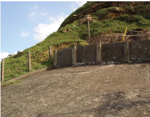
鼻頭角燈塔後方坡地雨水集中坪。
