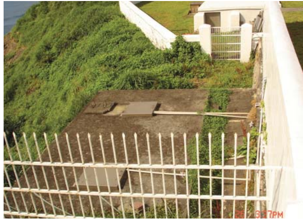
20噸雨水地下貯槽，現已改為自來水貯槽。（鼻頭角燈塔）
