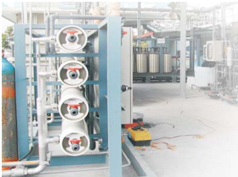
自來水高級淨化處理模廠-LPRO、UF、奈米浮除
