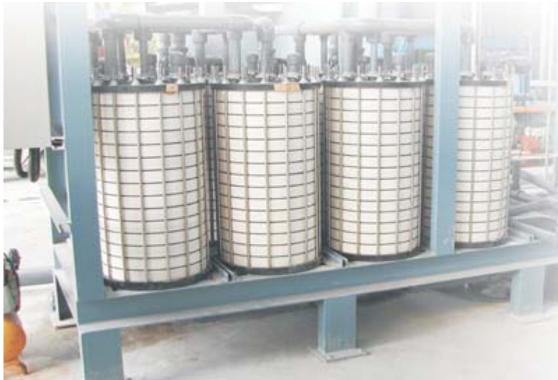
自來水高級淨化處理模廠-UF 前處理膜組
