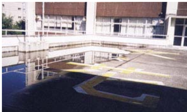
▲ 日本雨水博物館的屋頂收集雨水展示
