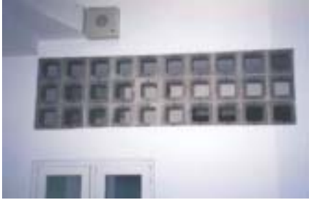
▲建築物內隔間牆上方採用通風透氣磚設計，促進室內通風良好
