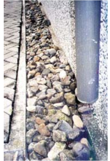
▲ 透水溝渠配合漫地流雨水滲透磚之應用(社寮國小)
