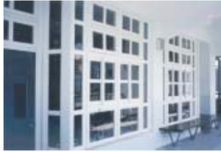
▲教室大面積窗戶採光，增加室內光源，上方並採用可開啟氣窗，增加空氣流通
