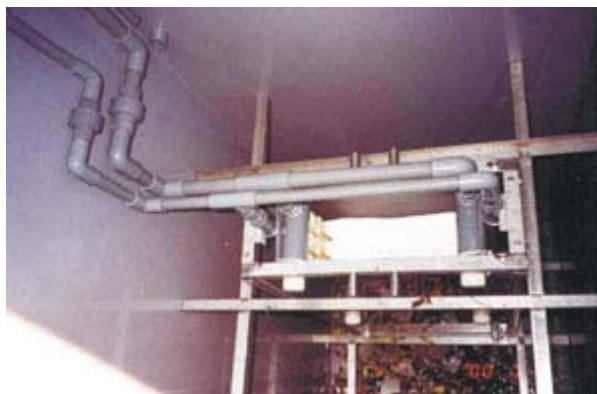
▲ 照片 4-3 沈浸式膜外觀
