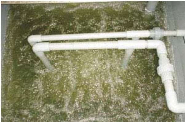
▲ 照片 4-4 沉浸式膜槽曝氣狀況
