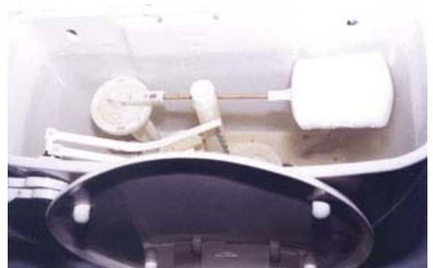
▲ 圖 9 二段式沖水器之換裝
