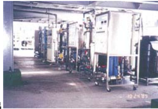
▲ 圖 4 現場模組現配圖
