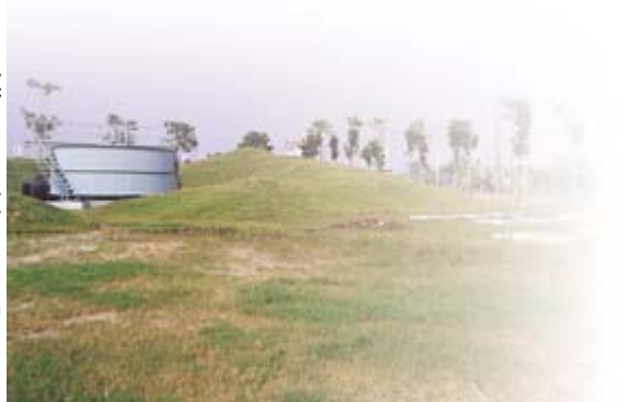
▲ 環球中水已達三級處理，該污水廠埋設地下並全面綠美化
