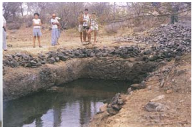
▲ 照片 17 農莊人工雨水貯留池供飲用及家畜用
