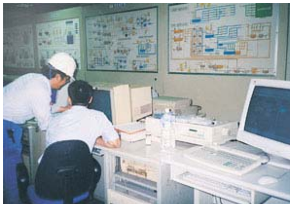
▲ 採用 DCS（分散式控制系統）監控所有冷卻水運作，以有效管理達成節水目的
