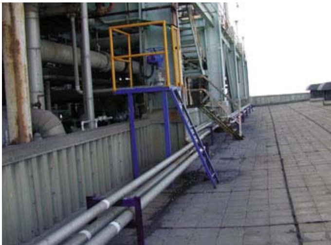
▶照片一：鍋爐沖放水排放管路及隔離閥增設情形
