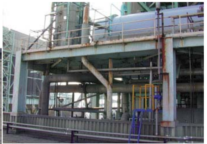
▶照片二：閃化槽與排放管路、隔離閥現場配置情形
