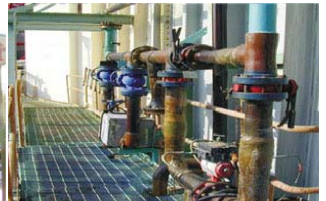
▶照片八：修改後 FGD 系統補水管路配置情形
