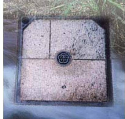
▶日本下水道人孔蓋
