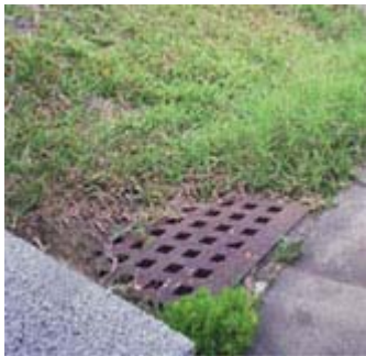
▶地面雨水逕流收集溝
