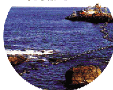
取水管之鋪設工程
