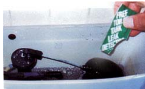
▶圖 8. 步驟四 漏水現象水封呈現藍色
