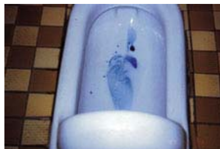
►圖 13. 蹲式馬桶微漏可見染液被細小水流沖散
